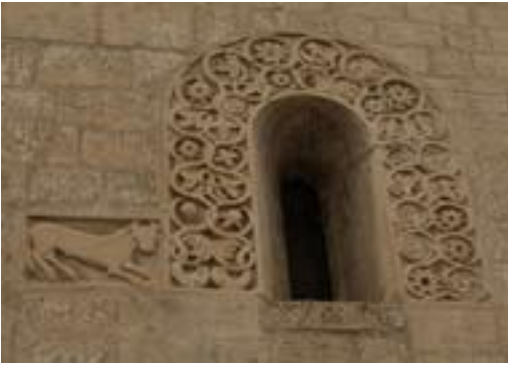
S. Leonardo - Monofora, scolpita sulla facciata
